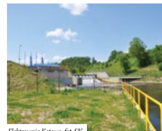
Elektrownia Kotowo, fot. SK
