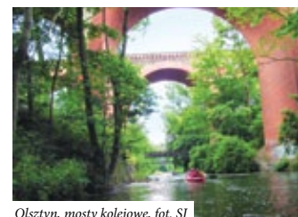
Olsztyn, mosty kolejowe, fot. SJ
