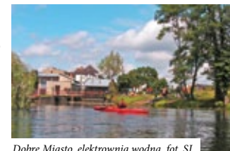
Dobrze Miasto, elektrownia wodna, fot. SJ
